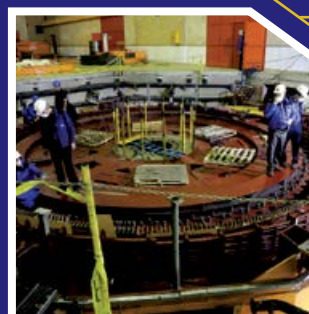
تعمیر و بازسازی سیم پیچ و هسته ژنراتورها تا ظرفیت ۲۵۰ مگاوات
