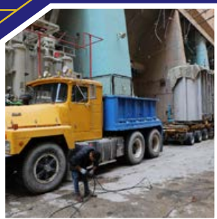
نصب و راه اندازی ترانسفورماتورهای قدرت نیروگاهی در سطوح ۱۳۲ - ۲۳۰ و ۴۰۰ کیلوولت
