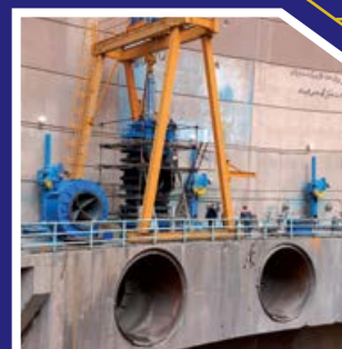
علاج بخشی و نصب شیرها و تجهیزات تخلیه تحتانی
