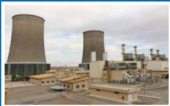
نیروگاه سیکل ترکیبی یزد
