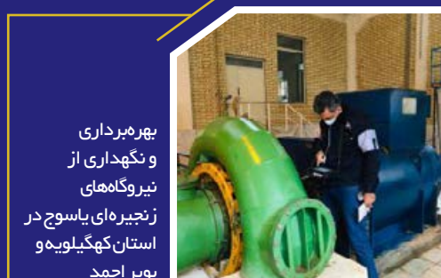
تعمیر و بازسازی سیم پیچ و هسته ژنراتورها تا ظرفیت ۲۵۰ مگاوات
