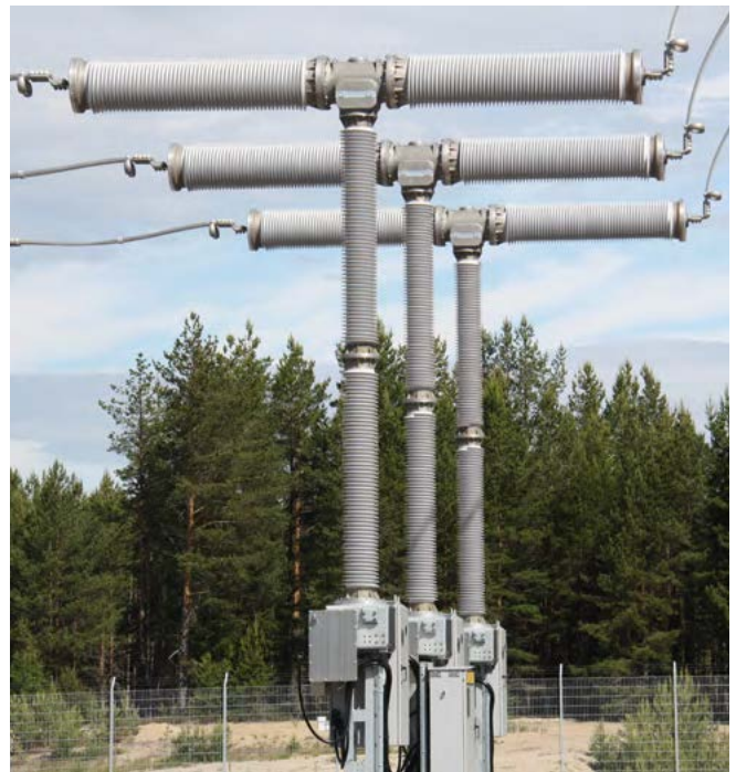
Fig. 4.1-23: 3AP2 DCB 420 kV
