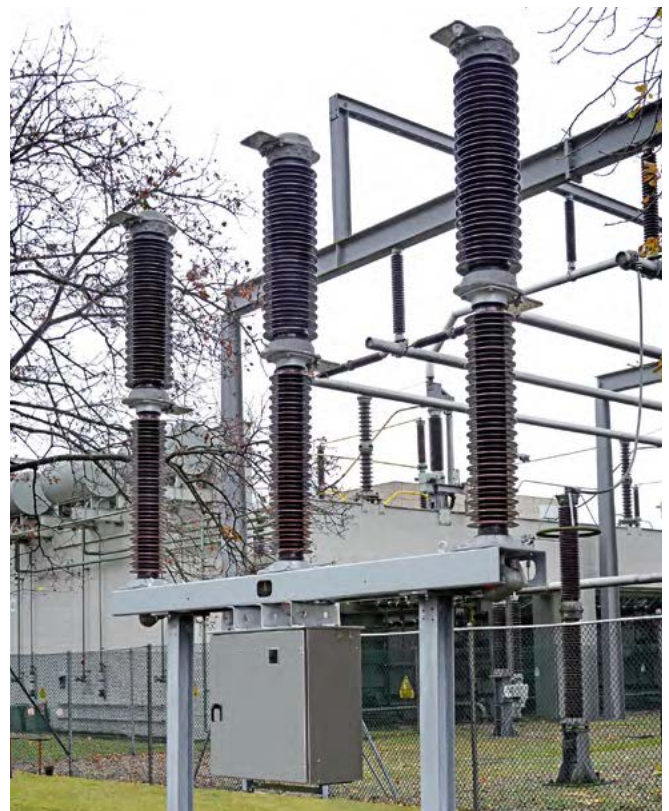
Fig. 4.1-9: 3AP1 FG 145 kV
