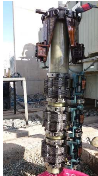
شکل ۱- شمای واقعی از دایورتر سوئیچ تپ V
