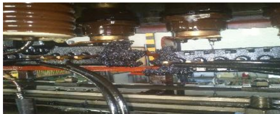
شکل ۳: نمای نزدیک از خطای گسستگی تپ‌چنجر
