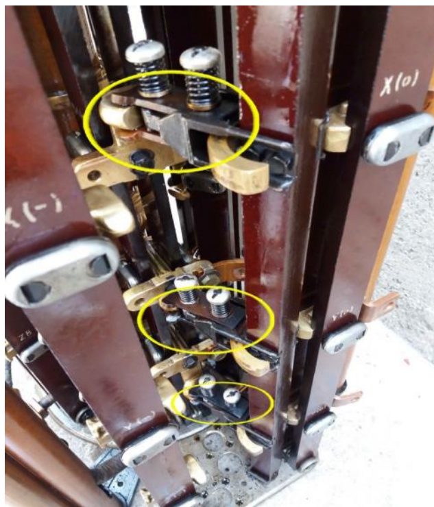
شکل ۳: کنتاکت کربونیزه شده و داراب رسوب در هر سه فاز ناحیه تپ سلکتور
