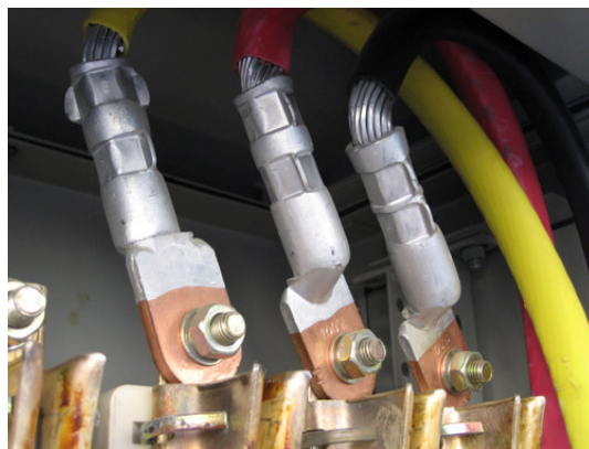
(شکل شماره ۵) خمش بیش از حد کابل آلومینیوم
