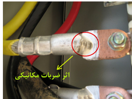
(شکل شماره ۳) اثرات ضربات مکانیکی بر کابلشوی بی متال
