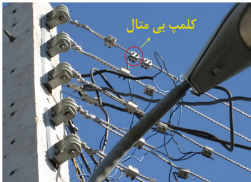
شکل شماره ۲) شبکه فشار ضعیف هوایی با سیم آلومینیوم
