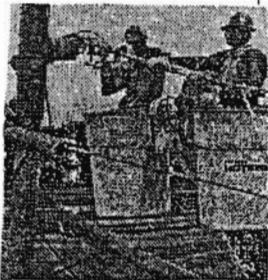
شکل ۴- استفاده از دستکش، آرنجبنده و پاکت در شبکه ۲۰ KV
