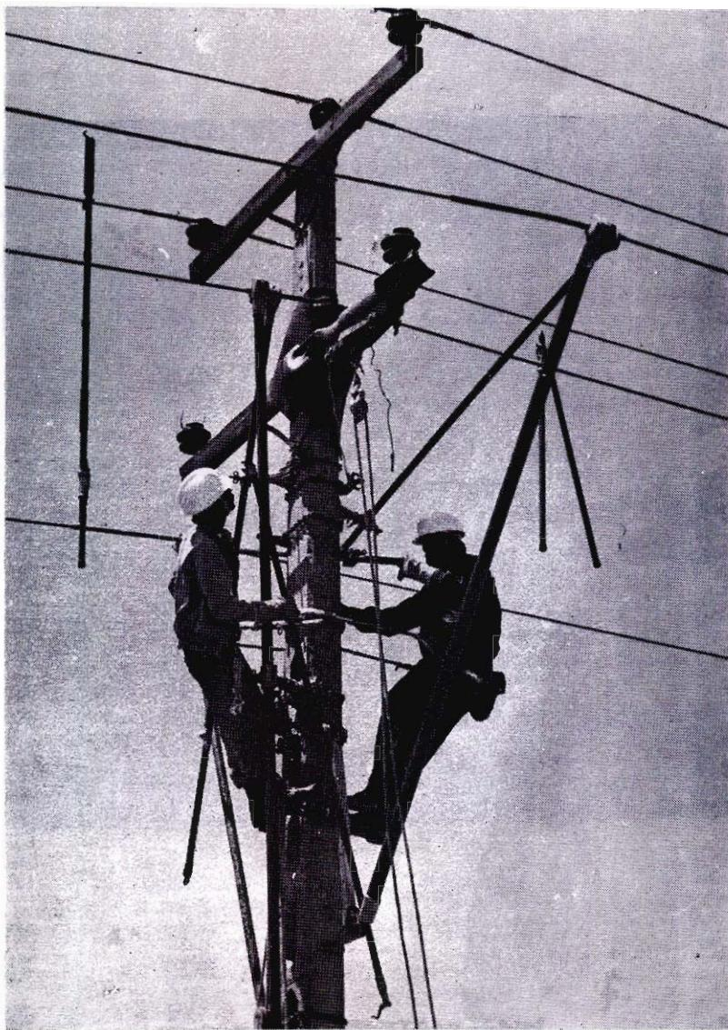
۴- روش تعویض مقره‌های معیوب دو مداره ۲۰ کیلوولت به طریقه گرم با جریان هر فیدر ۱۴۰ تا ۱۷۰ آمپر.
