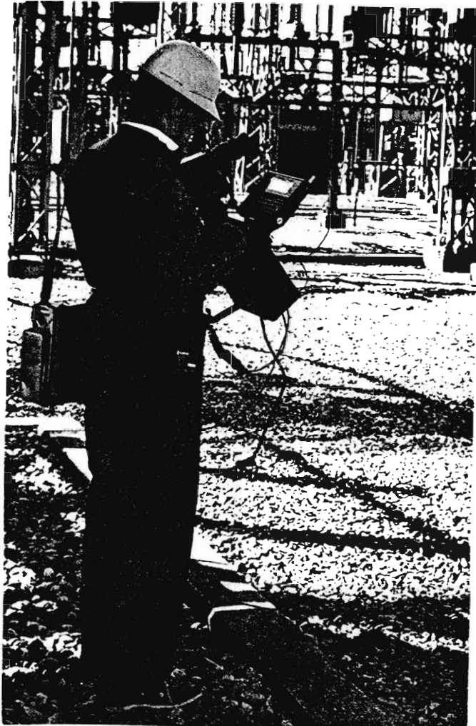
شكل شماره (۶) استفاده از دوربین ترموویژن در يك پست
